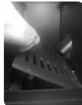
Das Scheitholzrost im Kessel positionieren
