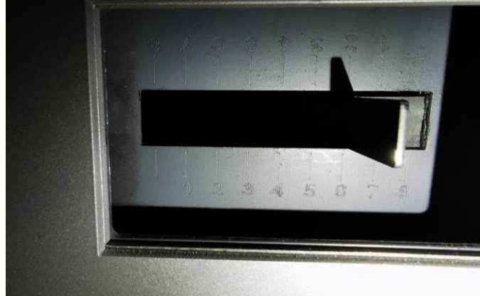
Abbildung 10: Einstellung der Primärluftmenge
