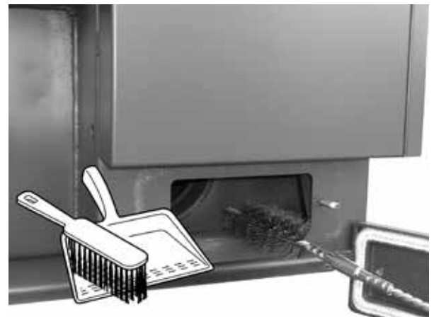
Muster – die Reinigung des Rauchkanals – unterer Deckel
