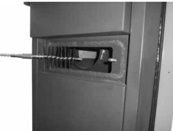
Muster – die Reinigung der mittlerer Teil des Rauchkanals – mittlerer Deckel
