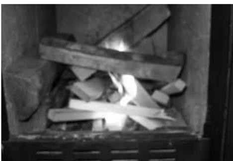
Abb. 27: Brennholz locker einlegen
