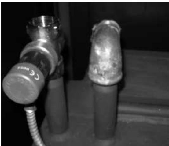
**Abb. 3: Thermische Ablaufsicherung, Montage im Kessel**
