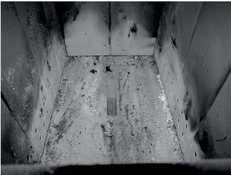
Bild 6. Richtig gereinigte Ladungskammer
