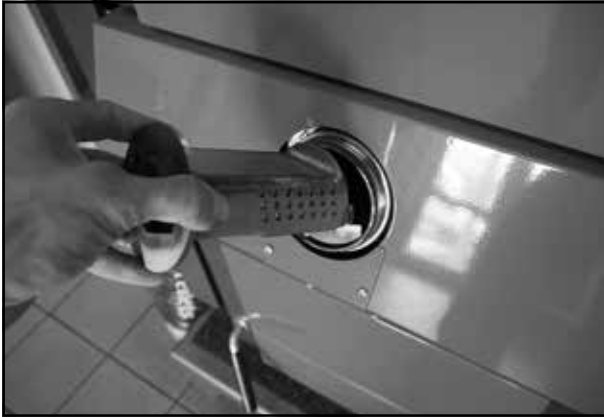
Die Zündkammer in den Kessel einstecken
