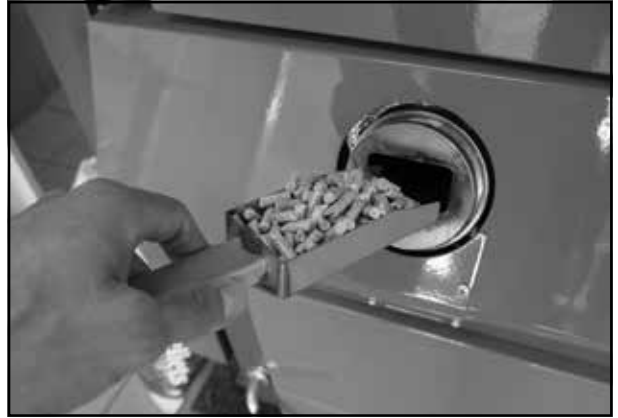
Die Zündkammer mit Pellets zur Entzündung befüllen
