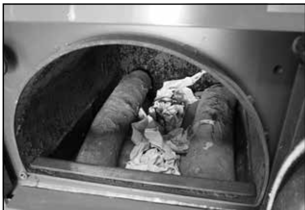
Der Raum zwischen den Scheiten mit dem Zeitungspapier ausfüllen
