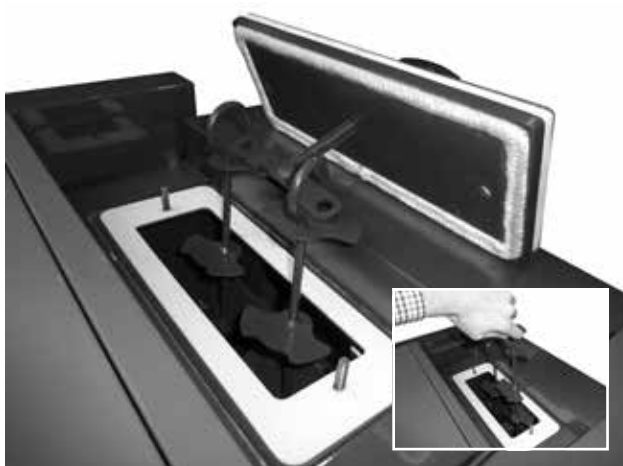
Beispiel des Herausnehmens der Brennelemente aus dem Rohraustauscher (Rohrwand) vor der gründlichen Reinigung
