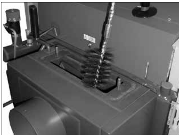
Vorführung der Reinigung des Rauchkanals mit Drahtbürste.
